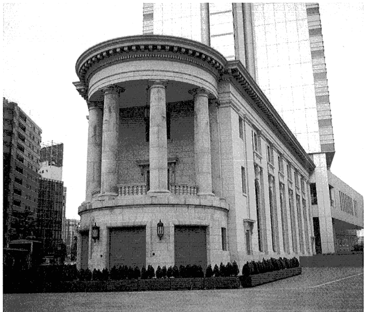
曳き屋して旧横浜銀行本店別館（元第一銀行横浜支店）遺して高層再開発し政策価値を高めた例
