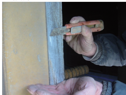
主屋2階窓枠塗料サンプル（1-1）
